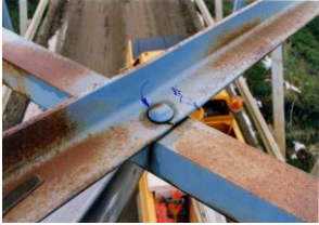
Fatigue Crack
