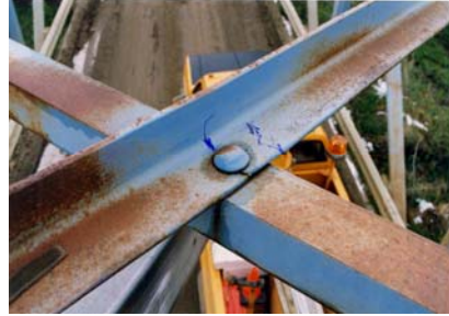
Fatigue Crack
